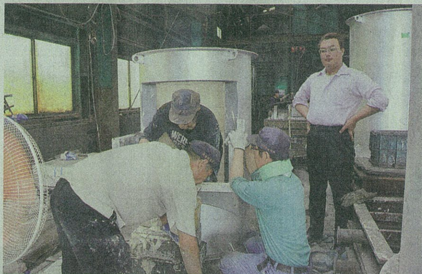
新しい溶解炉の内部に耐火れんがを張りつける作業を見守る、原田鋳造所の原田万稔社長(右)＝嘉島町
